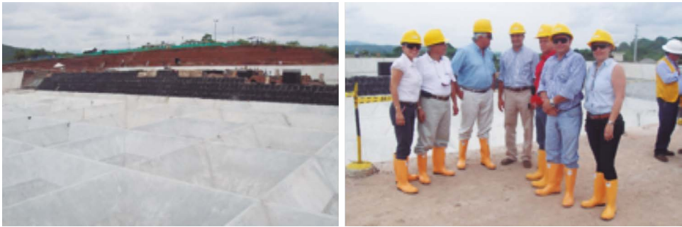
Visita de la ADT a las obras del Triángulo del Tolima, octubre 2010. Foto: archivo de la ADT
